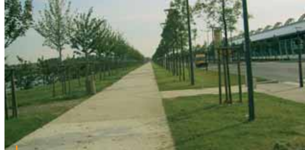
Cheminement en béton poreux
