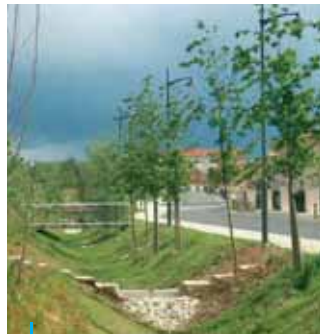
Noues cloisonnées, Parc Bouglière, Corbas
