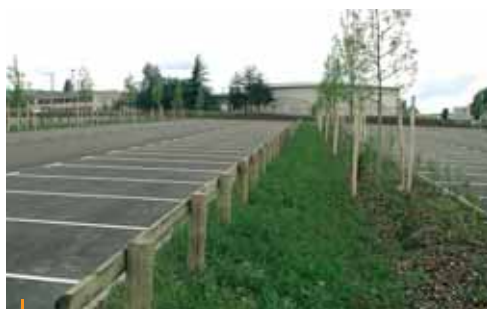
Parking avec un espace d'infiltration central, Neydens
