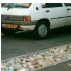
Tranchée d'infiltration
