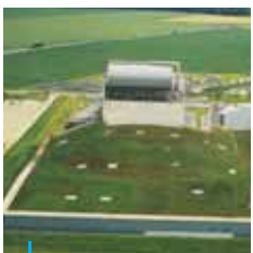
Toiture végétalisée de l'usine Monthyon
