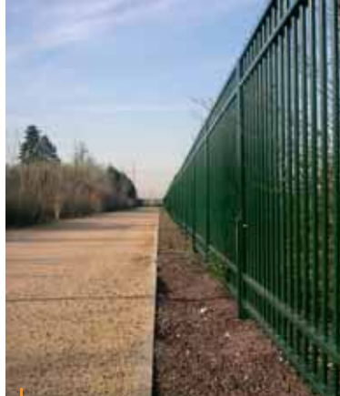
Tranchée d'infiltration, Saint-Priest
