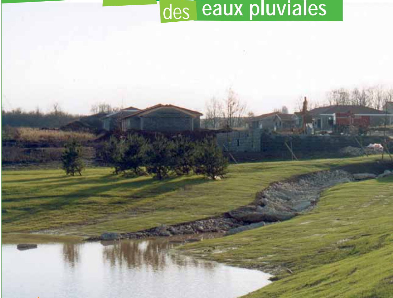
Bassin en eau « jardin des quincias », Villefontaine
