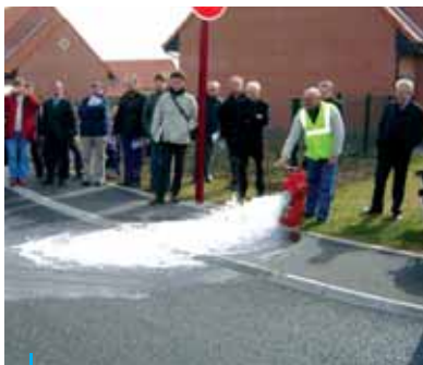
Démonstration de la perméabilité des enrobés poreux sur la résidence Delestraint, Lambres-lez-Douais
