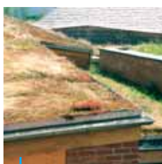
Toitures végétalisées, lycée Jacquard, Caudry
