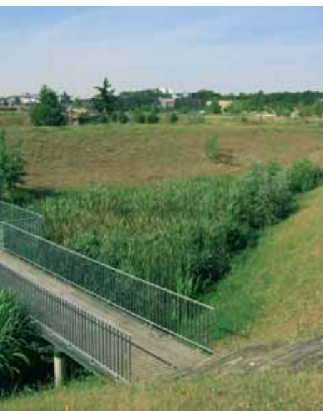
Infiltration des eaux dans une zone humide
