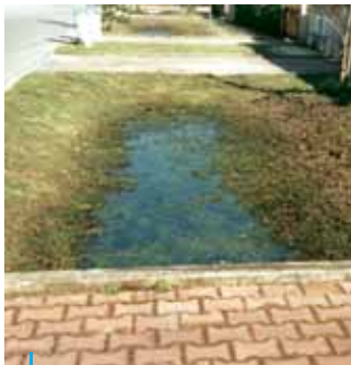
Noue en eau, Bordeaux
