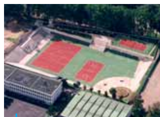
Bassin sec aménagé en terrain de sport, Clichy-sous-Bois
