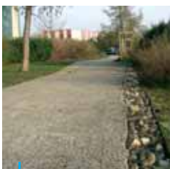
Cheminement piéton bordé d'une tranchée d'infiltration, ZAC des Chênes, Corbas
