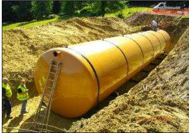
Photo d'une cuve enterrée de 120 m 3
