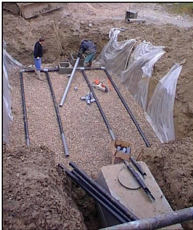
Filtre à sable vertical drainé en cours de réalisation
